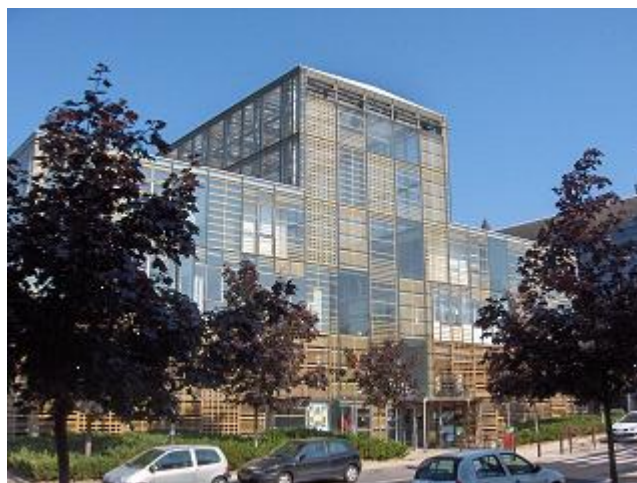
Université Marne La Vallée – Bâtiment Lavoisier
