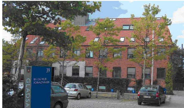
Rosenkæret office building, Gladsaxe
